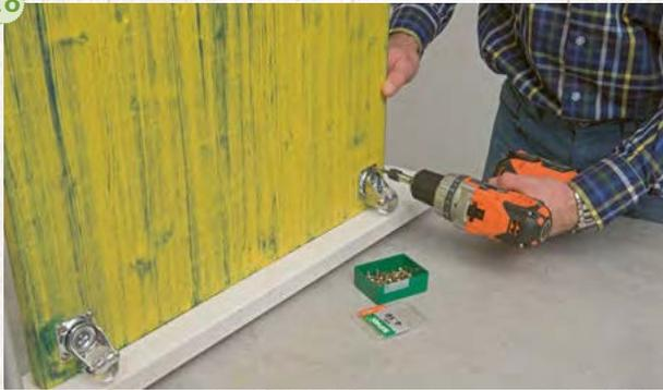
18. Las ruedas giratorias le dan movilidad a tu mesita. Éstas se fijan con tornillos en las esquinas del tablero inferior a una distancia de aprox. 1 cm a los lados.
