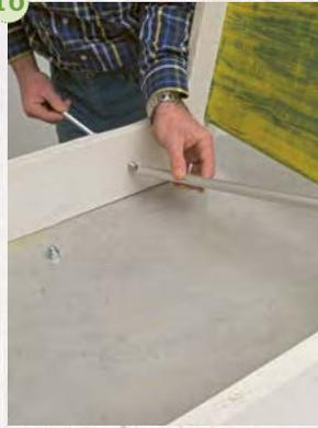
16. Empuja las varillas roscadas a través de ambos costados de la mesa. No te olvides de los tubos de aluminio en medio. Si la barra se atasca en el lado opuesto de la mesa, usa un martillo de goma para ayudar a que pase la barra.
